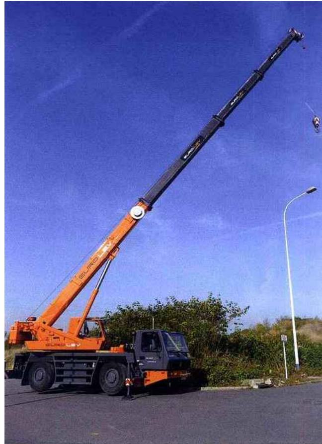
Pour les clients qui ne disposent pas de personnel qualifié à l'utilisation de machines spécifiques, le loueur propose la location avec opérateur. Ce dernier prend alors en charge la livraison des produits, leur installation et leur manipulation.
